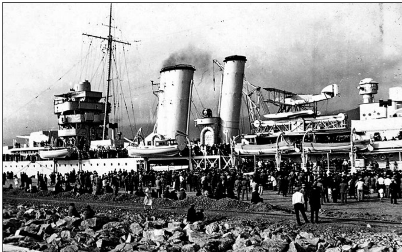
York w chilijskim porcie Antofagasta, 1930 rok. Fotografia jest o tyle interesująca, gdyż w doskonały sposób ukazuje działa przeciwlotnicze, dalmiżnice oraz wodnosamolot na katapultach. Fot. Internet
