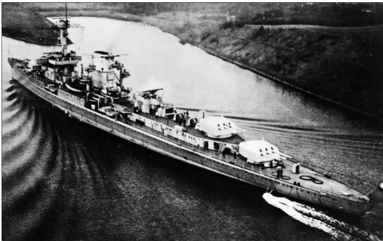
Leipzig w Kanale Kilońskim w rejonie Rendsburga, widoczne rozmieszczenie uzbrojenia, brak katapulty.
